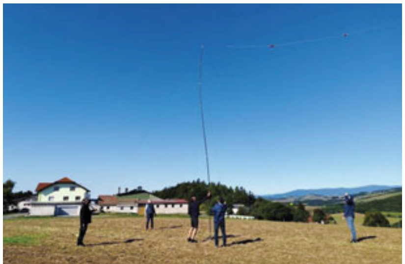
Nachjustierung des Fächerdipols nach stärkeren Böen
