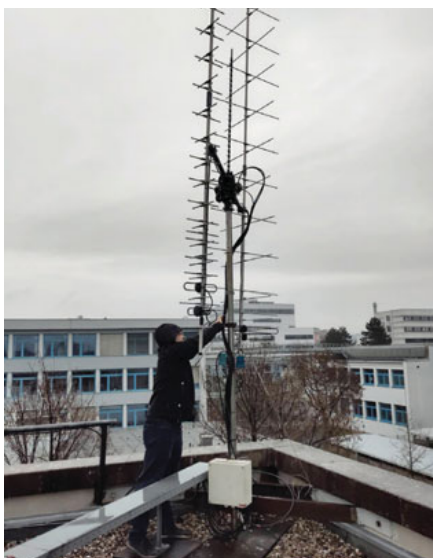
OE6CBX bei der Filtermontage an der TU Graz
