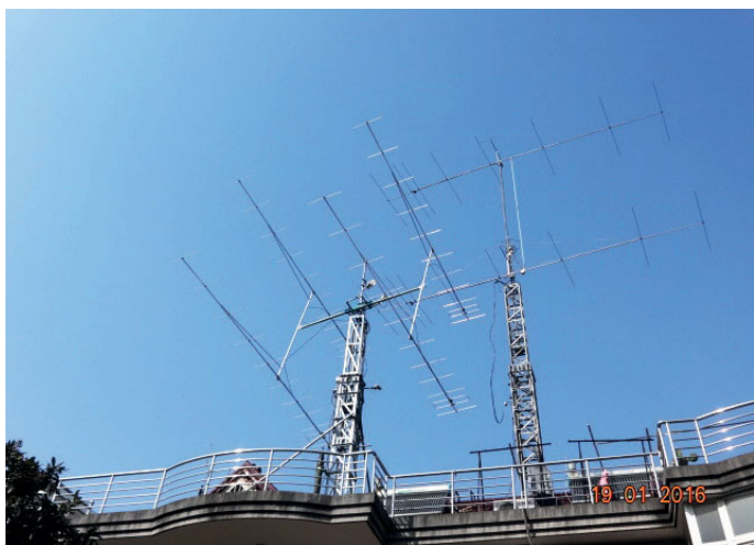
Die Antennenanlage von BA4SI Li mit 2x 8 El. gestockten Yagi Beams
