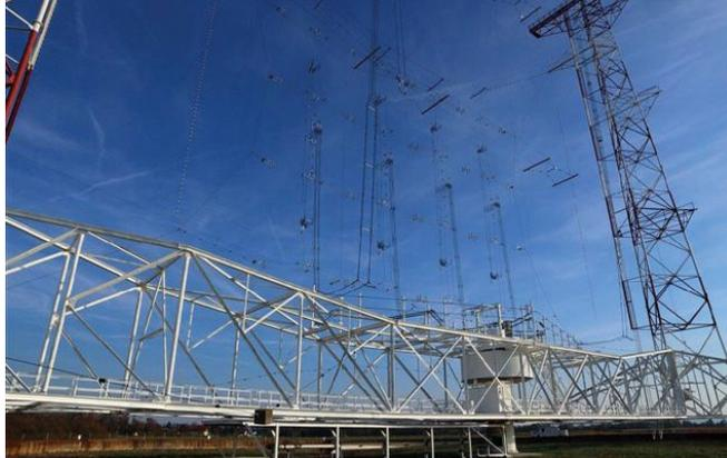
in die nicht in Betrieb gewesenen Endstufen der 100kW- und 500kW-Sender. Mit der drehbaren Antenne, welche auf eine Schiene mit 85 m Durchmesser, mit einer Gesamthöhe von ca. 80 m und mit 4 Motoren betrieben wird, durften wir auch eine Runde mitfahren.
