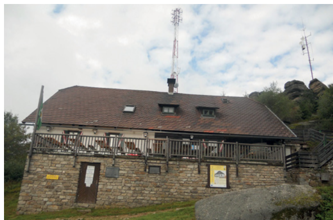
Nebelsteinhütte rechts davon die Antennen von OE3XNR
