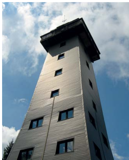
Die neue Antenne
