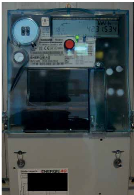
Bild 1: Foto eines „AMIS-Stromzählers“. Es gibt unterschiedliche Ausführungen.
