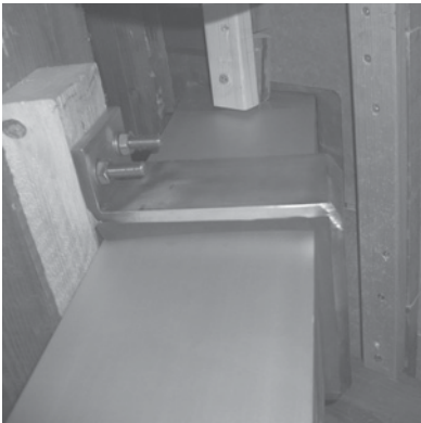
Mastschelle Firstbalken und Dachdurchführung.
