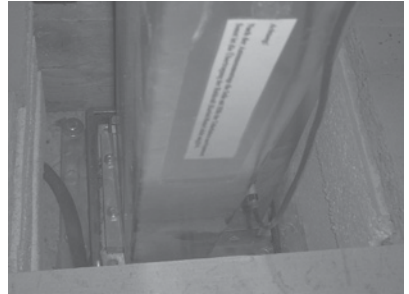
Mastfuß in Bodenwanne.
