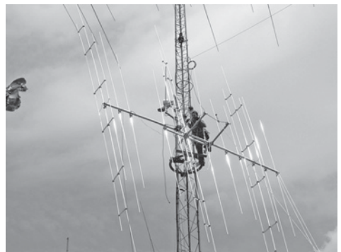
Optibeam bei der Montage.
