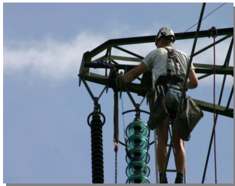
Bild11 Austausch der Glaskappenisolatoren
