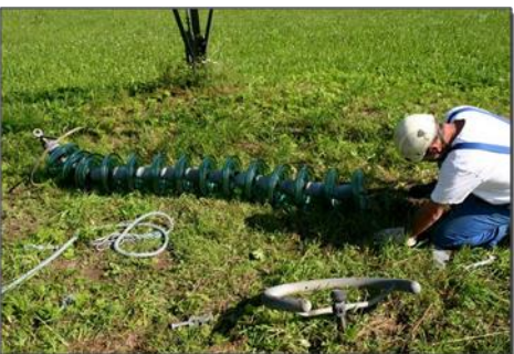
Bild12 Demontage eines Glaskappenisolators
