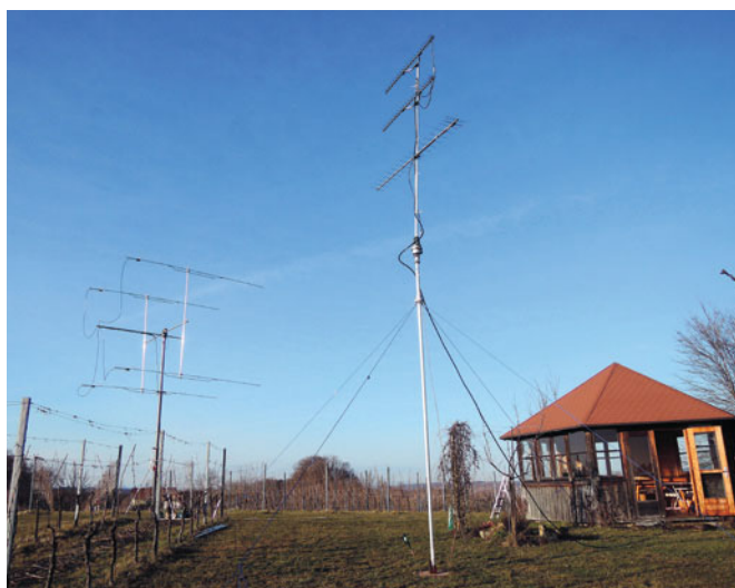
Funkpavillon mit portabler 2 m-EME-Anlage und UHF-Antennen
