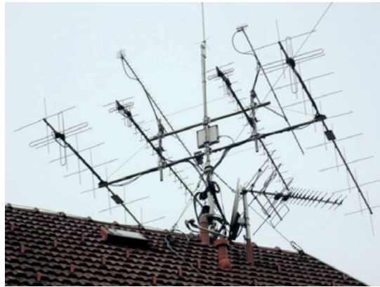
links: die Antennenanlage OE6FNG – Antennen von 144 MHz bis 2400 MHz
