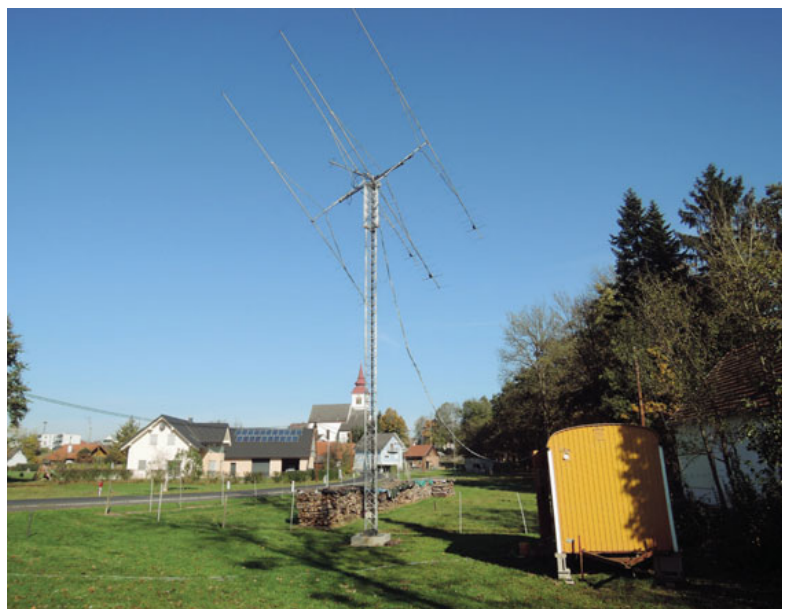
oben: 4x 17B2 Cushcraft auf 12 Alu-Mast in JN76XR Halbenrain.
