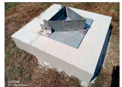
rechts: Das fertige Fundament mit Kippgelenk für den 12m-Alu-Mast.
