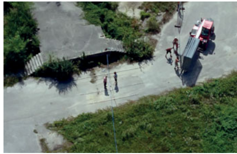
Per Seilzug wird die Antenne in luftige Höhen befördert
