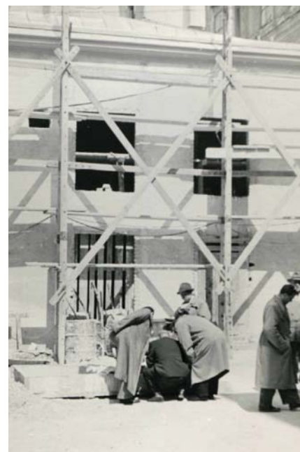
Baustelle Verbandsheim Naglergasse
