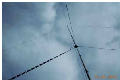
G5RV – GFK-Mast auf 2 Ebenen je 4 x abgespannt
