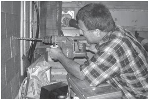
OE6WVG bohrt Durchgang für das „Ecoflex15“. 230 V gibt es leider nur, wenn das Hausaggregat läuft.
