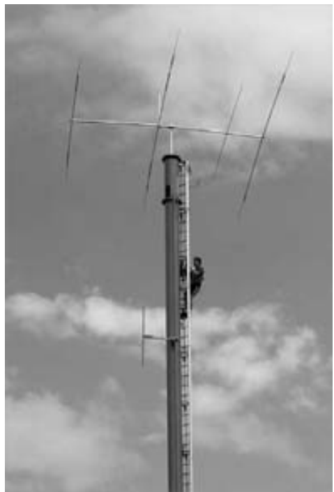
Bild 1: Montagearbeiten am Mast
