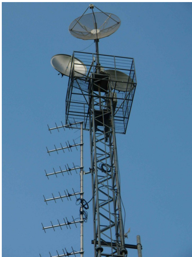
Mikrowellenantennen bei OK5Z
